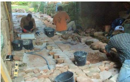
Calade en cours de construction, Rousselongue, Ardèche
