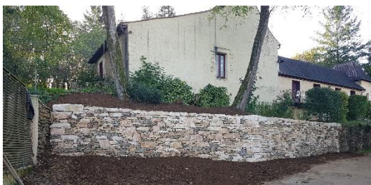
Exemple de mur accessoire au bâtiment, Ent. Muremuret en Périgord, Dordogne
