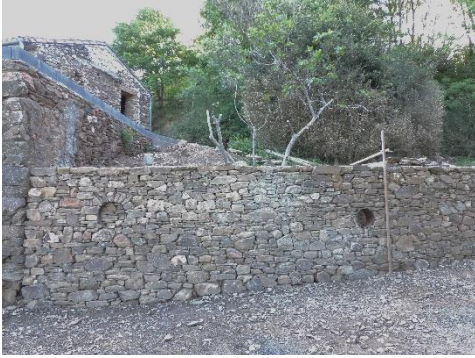
Mur accessoire au bâtiment, ent. Erwan Henou, Tarn.
