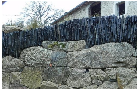
Mur de soutènement en pierre sèche, granit et lauze de phonolite, ent. Edouard Duterte, Tence, Haute-Loire
