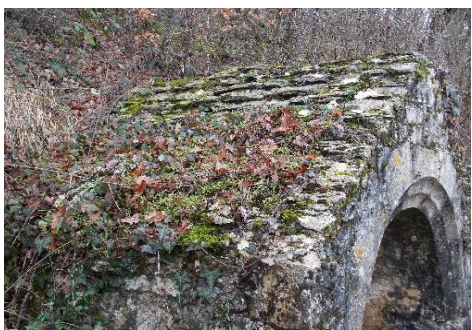
Fontaine La Capelette, Rocamadour, Lot. Petit patrimoine de pays dont la toiture en lauzes est à rénover entièrement
