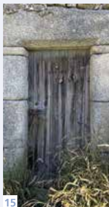
14. Porte du début du XIX e s. en châtaignier brut : les lames sont encore larges et de coupe artisanale (Le Masseguin).
