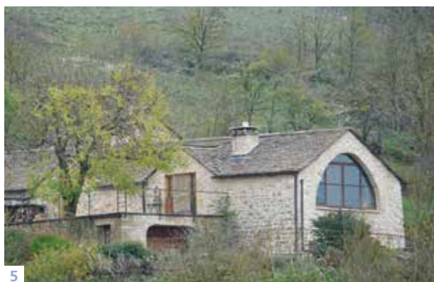
5. Traitement contemporain d'une baie de grandes dimensions, en aluminium, posée en retrait de l'arc brisé (causse Méjean).
