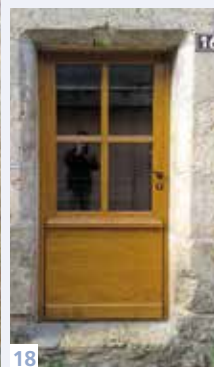
14. Porte du début du XIX e s. en châtaignier brut : les lames sont encore larges et de coupe artisanale (Le Masseguin).
