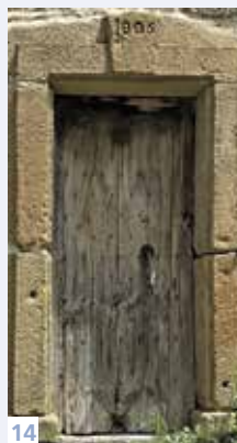
14. Porte du début du XIX e s. en châtaignier brut : les lames sont encore larges et de coupe artisanale (Le Masseguin).
