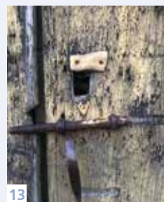
11. 12. 13. Systèmes de fermeture simples, à targette, observés sur des bâtiments agricoles.
