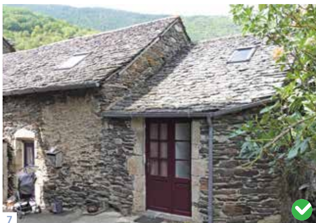
6, 7. Les châssis sur le pan de toit de la photo 6 ne conviennent pas. Ils sont trop nombreux et ne devraient pas être posés en surimposition mais être intégrés à la toiture comme sur la photo 7.
