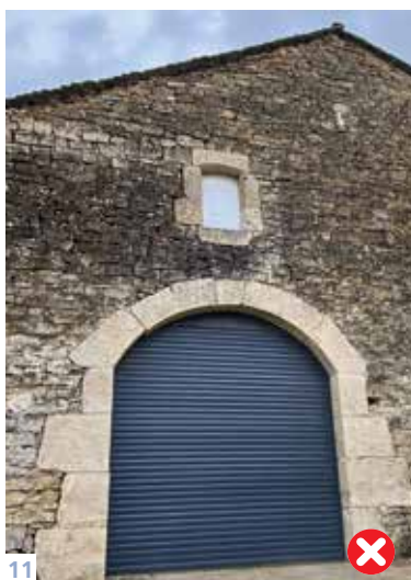
11, 12, 13. Volets roulants : en aluminium (11), en PVC (12), avec coffre saillant (12, 13). Sur la troisième photo, les fenêtres sont d'un type, d'une forme et de dimensions, inadaptées au bâti ancien.
