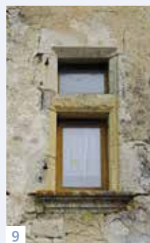
9. 10. Châssis contemporains en bois, avec vitres grand jour sur la fenêtre à traverse (photo 9, causse de Sauveterre) et petits bois sur la fenêtre à meneau (photo 10, mont Lozère).
