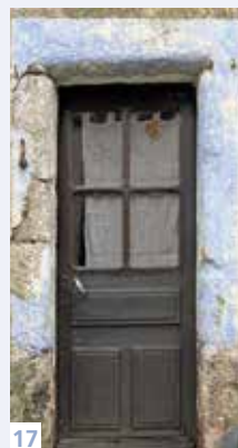
14. Porte du début du XIX e s. en châtaignier brut : les lames sont encore larges et de coupe artisanale (Le Masseguin).
