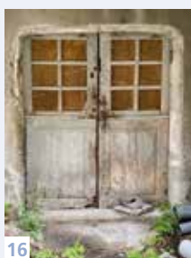
14. Porte du début du XIX e s. en châtaignier brut : les lames sont encore larges et de coupe artisanale (Le Masseguin).
