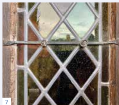
6. Fenêtres à croisée, à traverse, et à meneau, en kersantite (reconstruction, corniche des Cévennes). 7. Détail d'une vitre sous plomb, tenue par une vergette. 8. Vue intérieure d'une fenêtre à croisée avec volet intérieur.
