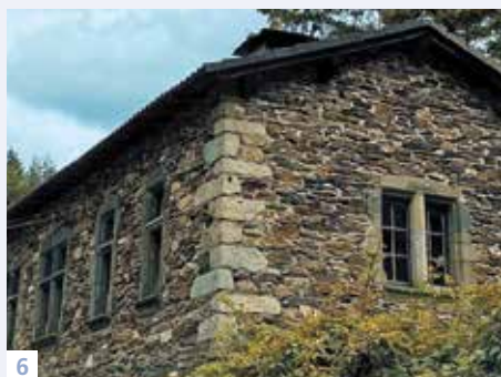
6. Fenêtres à croisée, à traverse, et à meneau, en kersantite (reconstruction, corniche des Cévennes). 7. Détail d'une vitre sous plomb, tenue par une vergette. 8. Vue intérieure d'une fenêtre à croisée avec volet intérieur.
