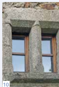
9. 10. Châssis contemporains en bois, avec vitres grand jour sur la fenêtre à traverse (photo 9, causse de Sauveterre) et petits bois sur la fenêtre à meneau (photo 10, mont Lozère).
