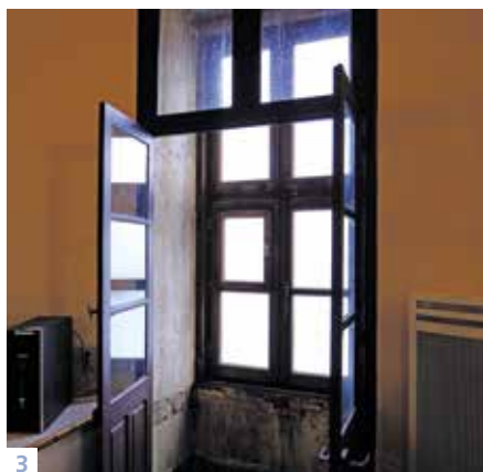
2. 3. 4. Double porte-fenêtre sud, au deuxième étage de la tour de l'Observatoire de l'Aigoual. Les exemples de double fenêtre sur le territoire du Parc national sont exceptionnels. Celui de ce bâtiment patrimonial, exposé à des conditions météorologiques extrêmes, en est le plus emblématique.
