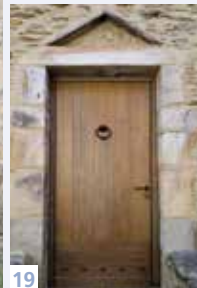
15. Porte de la deuxième moitié du XIX e s. : les lames verticales sont plus fines et calibrées. La peinture grise qui la recouvrait est toujours visible en haut de la porte, sous le linteau (mont Lozère).
