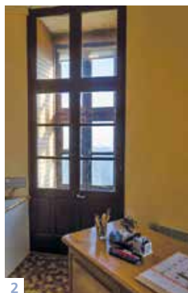
2. 3. 4. Double porte-fenêtre sud, au deuxième étage de la tour de l'Observatoire de l'Aigoual. Les exemples de double fenêtre sur le territoire du Parc national sont exceptionnels. Celui de ce bâtiment patrimonial, exposé à des conditions météorologiques extrêmes, en est le plus emblématique.
