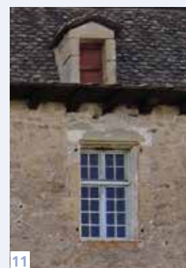
11. Fenêtre entretenue d'une demeure noble (deuxième moitié du XVII e s.), en bois, sur le modèle d'une ancienne croisée en pierre. Carreaux vitrés à petits bois.
