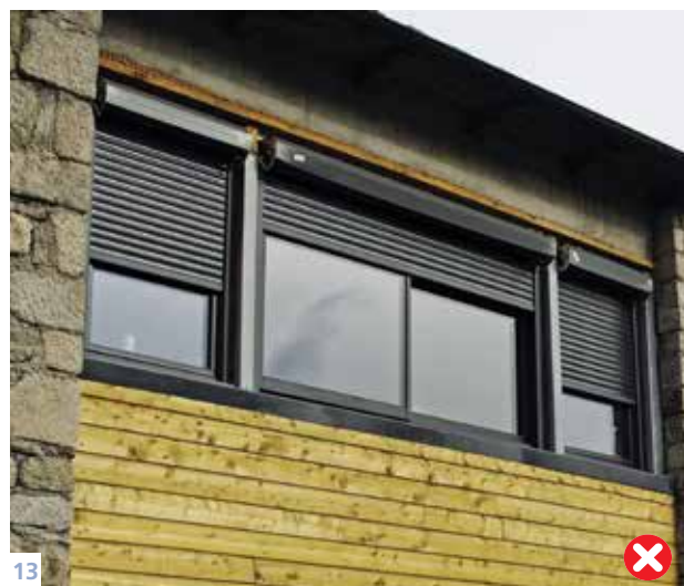
11, 12, 13. Volets roulants : en aluminium (11), en PVC (12), avec coffre saillant (12, 13). Sur la troisième photo, les fenêtres sont d'un type, d'une forme et de dimensions, inadaptées au bâti ancien.
