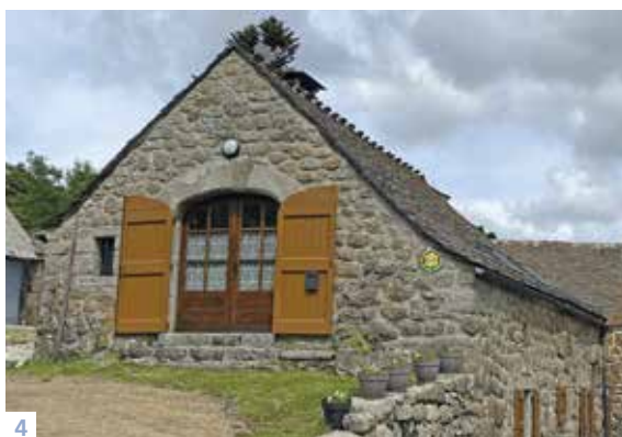
4. Transformation d'une porte de grange en porte-fenêtre, de type « fermière », à petits bois et simple vitrage. Des contrevents respectant la forme de l'encadrement ont été ajoutés (mont Lozère).
