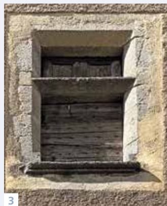
1. Baie trilobée, de la fin du XIV e s. (ou début du XV e s.), vitrage en losange sous plomb (vallée du Lot). 2. Petite baie dans un encadrement noble, sans vitrage, fermée par un volet intérieur (vallée Française). 3. Baie à traverse, avec encadrement en pierre chanfreiné, fermée par des volets intérieurs en lames de châtaignier (vallée Française).
