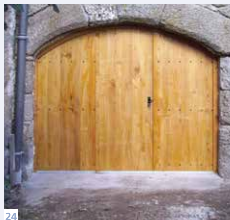
20. 21. 22. Les portes de grange ou d'étable, de grandes dimensions, sont de forme carrée (proportions de 1x1). 20. Causse Méjean. 21. Le Masseguin. 22. Hautes vallées cévenoles : la porte a été peinte en rouge au moyen d'une peinture naturelle à l'ocre ou à l'oxyde. 23. Porte chaulée à larges lames (vallée du Lot). 24. Portail contemporain, en lames de châtaignier de largeurs inégales, épousant la forme de l'encadrement (mont Lozère). 25. Création de baies contemporaines en aluminium, liée à la transformation d'un bâti ancien agricole en habitation (mont Lozère).
