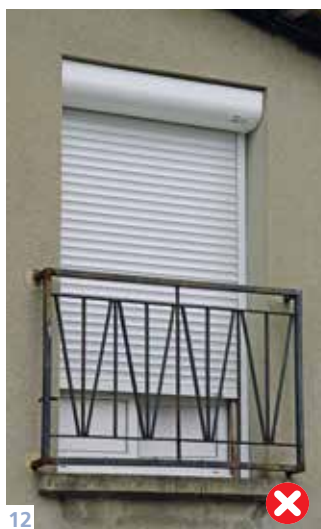
11, 12, 13. Volets roulants : en aluminium (11), en PVC (12), avec coffre saillant (12, 13). Sur la troisième photo, les fenêtres sont d'un type, d'une forme et de dimensions, inadaptées au bâti ancien.
