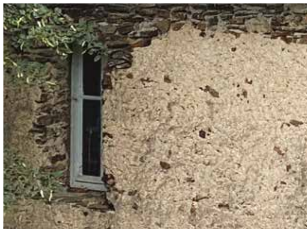
Enduit de chaux et sable (gravette) de schiste.
