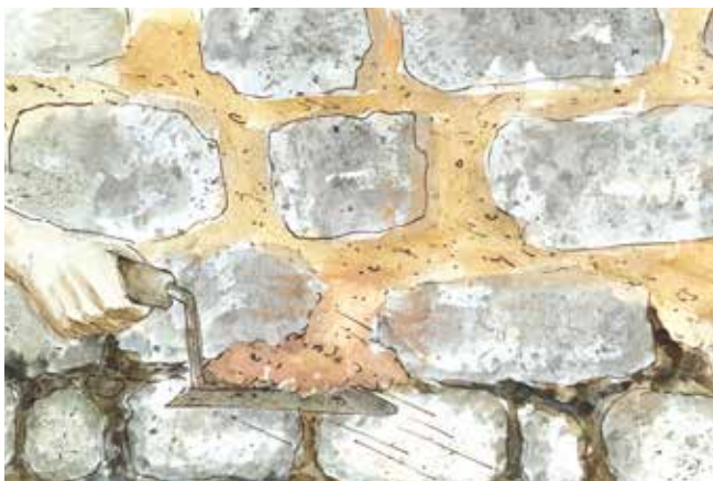
Rejointolement sur un mur en granite. Les joints sont « beurrés » c'est-à-dire bien garnis. Après le rejointolement, on peut brosser les pierres pour les nettoyer : on évitera les joints qu'il ne faut surtout pas creuser.
