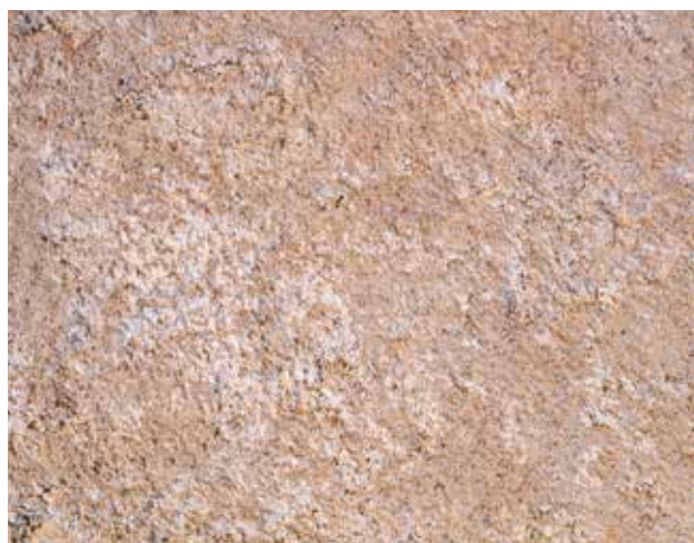
Enduit « jeté-recoupé » : texture grenue.
