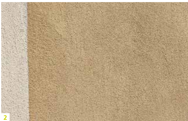
1. Façade à l'enduit lissé ancien. 2. Texture vue de près : l'enduit a été peint à fresco au badigeon de chaux.
