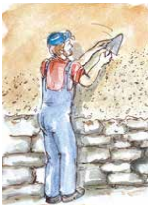
L'enduit est lissé avec la tranche de la truelle.
