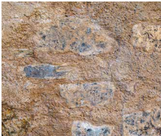
Enduit de rejointolement neuf, à fleur des têtes de pierres sur maçonnerie mixte (Journée de formation sur les enduits au château de Florac).
