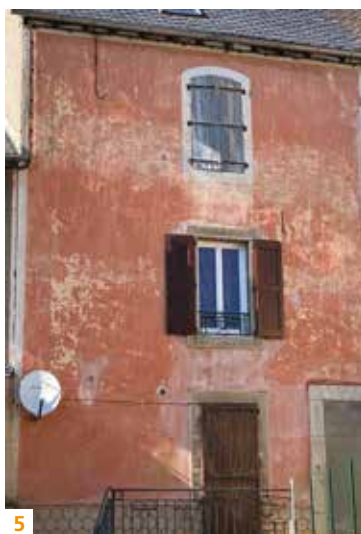
5. Façade ocre rouge et encadrement peint à la chaux blanche (cause Noir). 6. Façade d'une habitation dans le village, avec chaîne d'angle peinte en trompe l'œil (mont Lozère). 7. Décor d'architecture en trompe l'œil : parement ocre jaune clair, bandeaux horizontaux et entourages de fenêtres ocre rosé, chaîne d'angle harpée avec pierres à bossage plat de couleur ocre jaune foncé et gris, soubassement imitant des pierres de taille, de couleur grise (chaux et noir de fumée ou de vigne), gorges du Tarn.
