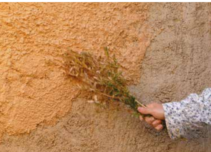
Dressage et enduit de finition fouetté à la branche de buis (Journée de formation sur les enduits au château de Florac).
