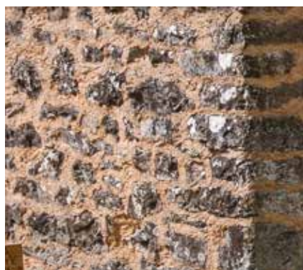
Exemples de rejointoiements sur le causse Méjean.
