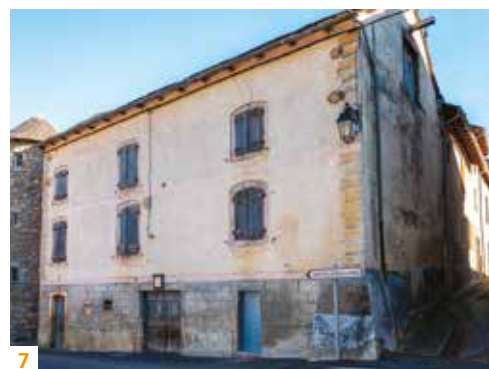
5. Façade ocre rouge et encadrement peint à la chaux blanche (cause Noir). 6. Façade d'une habitation dans le village, avec chaîne d'angle peinte en trompe l'œil (mont Lozère). 7. Décor d'architecture en trompe l'œil : parement ocre jaune clair, bandeaux horizontaux et entourages de fenêtres ocre rosé, chaîne d'angle harpée avec pierres à bossage plat de couleur ocre jaune foncé et gris, soubassement imitant des pierres de taille, de couleur grise (chaux et noir de fumée ou de vigne), gorges du Tarn.
