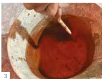
1. Préparation d'un badigeon de chaux ocre jaune et terre d'ombre, pour obtenir un ton « pierre ». 2. Pigments ocre rouge et ocre jaune. 3. Préparation d'un badigeon de chaux ocre rouge.
