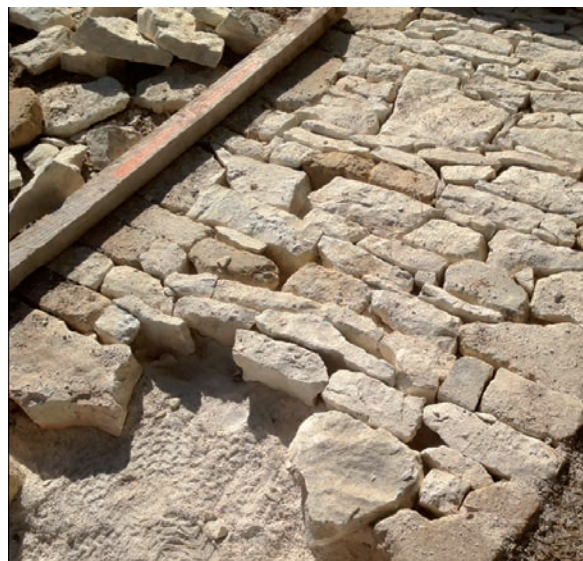
Réalisation d'une calade (48) © ABPS
