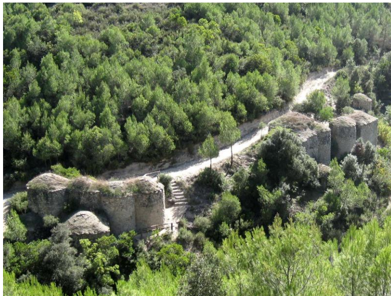
Tines dans leur environnement actuel ayant fait l'objet d'une restauration par le parc de Sant Llorenç
